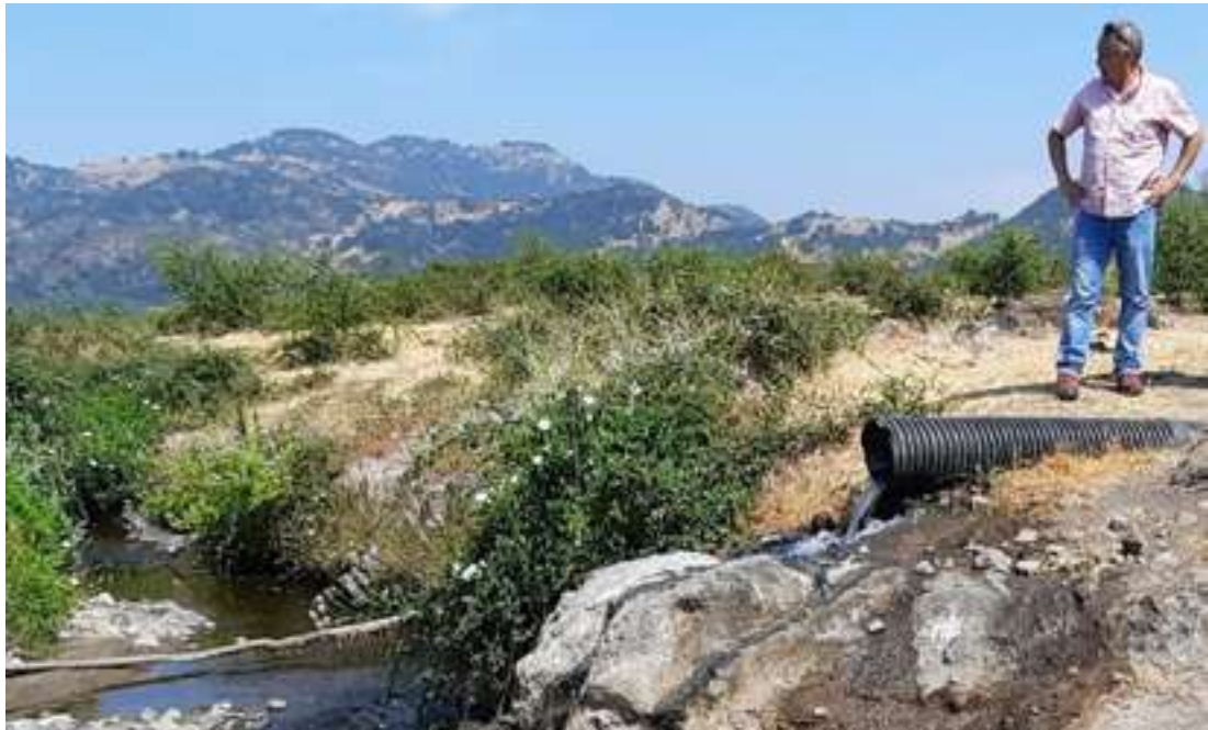
Punto de vertimiento de aguas desde relleno sanitario a canal
