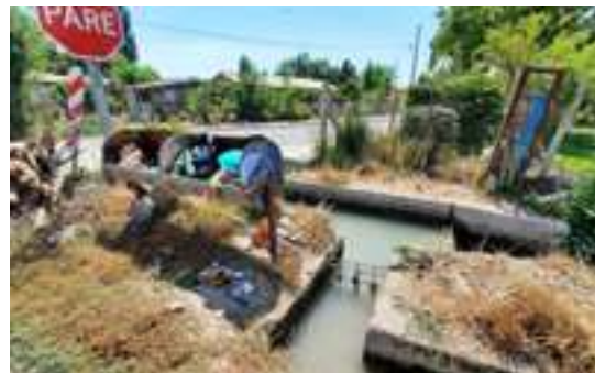
Punto de acumulación de basura en canal.
